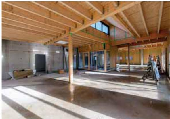
La Maison de la Petite Enfance est conçue dans une démarche Haute qualité environnementale. Tout est pensé pour éviter les déperditions de chaleur et limiter les besoins en chauffage : isolation, étanchéité à l'air, toiture végétalisée, panneaux photovoltaïques. Un maximum de matériaux issus des filières écologiques et respectueux de l'environnement sont utilisés... Un équipement exemplaire dont le chantier devrait s'achever à l'automne.
