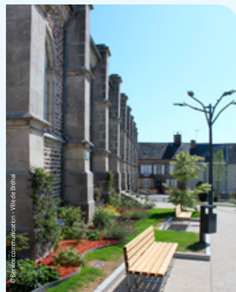
Centre-bourg de Bréhal réaménagé grâce aux politiques contractuelles.
