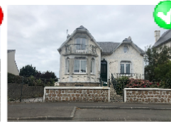
Clôture >2m moitié ferronnerie en haut et moitié mur plein en pierres en bas.
