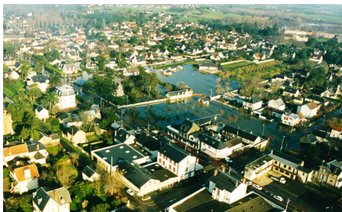
Jullouville – inondation de 1999
