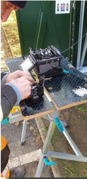
Les travaux ne se sont pas arrêtés pour autant puisque le câblage et la soudure des faisceaux de fibres dans l'armoire bat son plein. Pour information, il faut entre une et deux minutes pour souder une fibre. Il y en a plus de neuf cent à faire.... Il faut donc de la patience à tous les niveaux.
