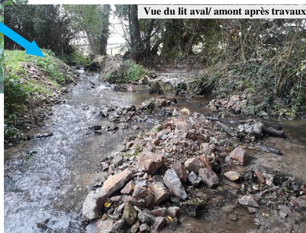
Vue du lit aval/ amont après travaux
