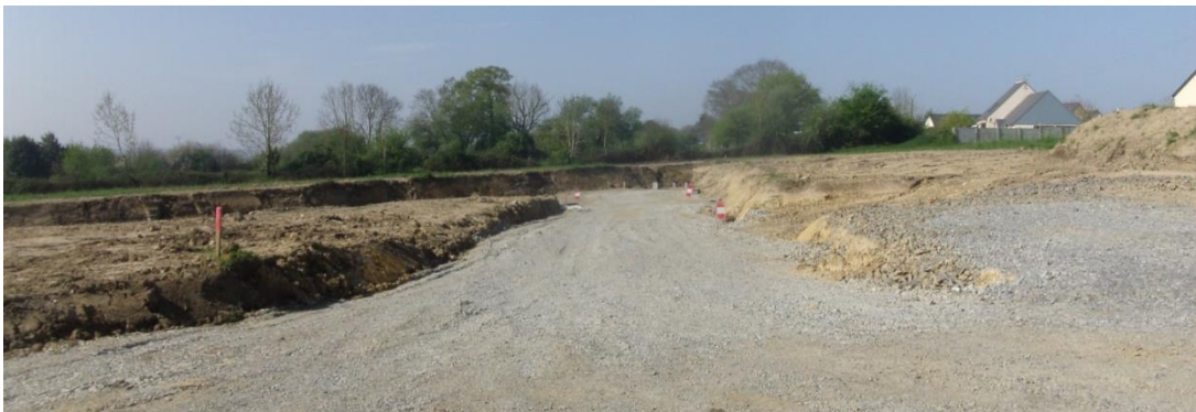
Vue sur secteur en cours de construction
