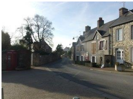
Implantation à l'alignement et en mitoyenneté sur la rue des Ecoliers
