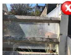
Clôture <1.60m moitié lisses PVC et plaques transparentes pleines et moitié mur plein enduit en bas.
