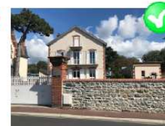
Clôture >1.60m dont les ornements reflètent les modénatures de la façade du bâtiment principal.
