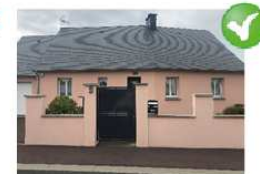
Enduit du mur de la même couleur que la façade principale de la maison.
